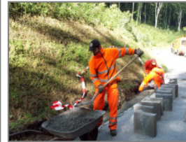
Verlegen von Böschungsrinnensteinen
