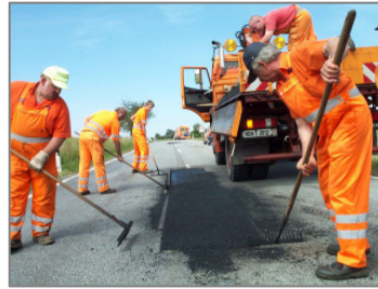
Teamarbeit: Ausbesserungen am Fahrbahnbelag
